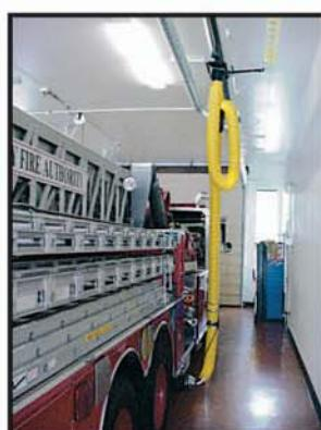
Вытяжной шланг EH серии в комплекте с пневмо-захватом "Grabber".
