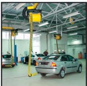
– Ряд различных типов **вытяжных устройств**, необходимых для удаления выхлопных газов от автомобилей на стационарных рабочих местах. В зависимости от конкретных условий применения и соответственно вариантов исполнения обладают различной зоной обслуживания, техническими характеристиками и дополнительными сервисными опциями, допускают многообразие вариантов монтажа и способов подключения.
