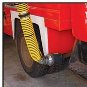
Пневмозахват GRABBER производства PlymoVent (Швеция).
