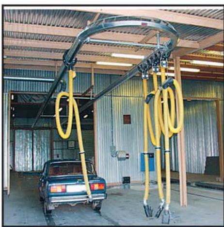
г. Москва. РосТелекомАвтобаза 21. Станция технического обслуживания оборудована типовым вариантом кольцевой системы удаления выхлопных газов LRS. Станция имеет сквозной проезд. Возвратный рельс смонтирован под углом к полу для самостоятельного возврата каретки ко въезду в гараж (на возвратный рельс каретки переводятся вручную).
