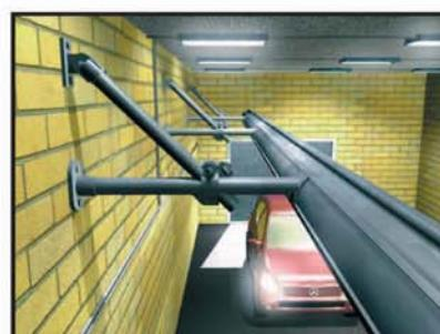
Крепление рельса-воздуховода к стене.
