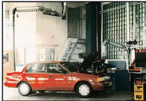
Санкт-Петербург. СТО "Форд". Вытяжное устройство VEGA на двухбалочной консоли с подключением к системе вытяжной вентиляции.
